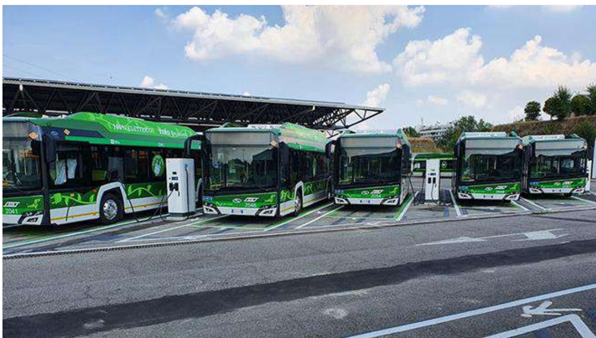
Foto 4: Petak Pengecasan Bas Elektrik
