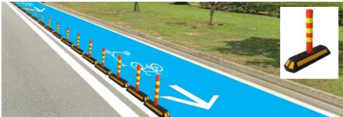
Foto 30: Cadangan penggunaan flexible post dengan lane block sebagai pemisah fizikal laluan on-carriageway
